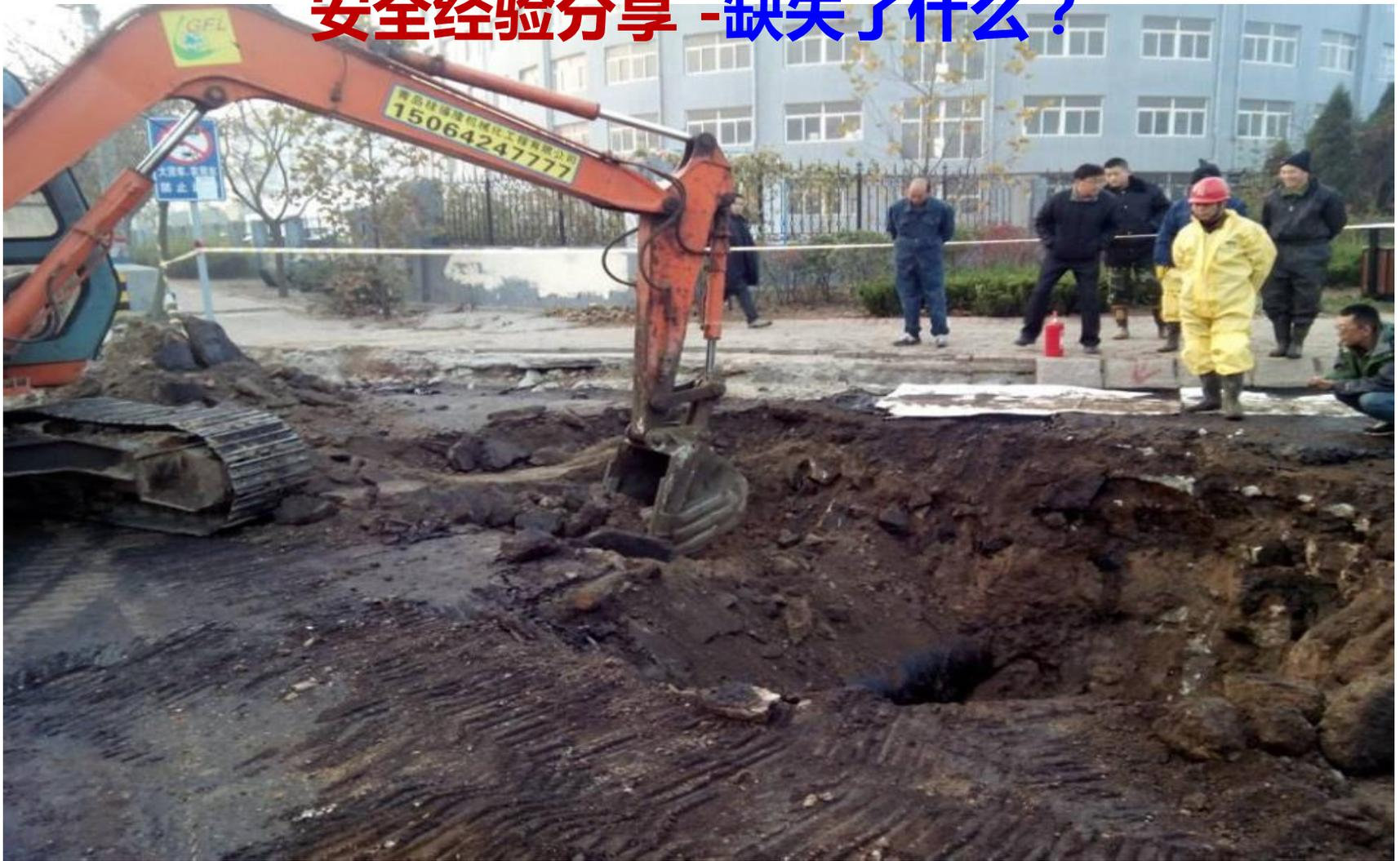
这可能是唯一一张照片，记录了中石化输油管线燃爆事故发生前漏油点的现场情景。中石化潍坊输油处安全科科长用手机摄于2013年11月22日7时32分。约3小时后，爆炸发生，照片中的施工人员几乎都已不在人世。
